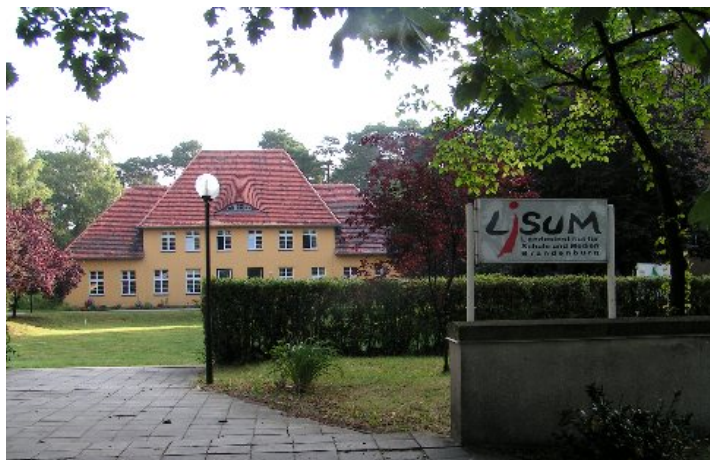
Der Eingangsbereich des Landesinstituts für Schule und Medien Brandenburg
